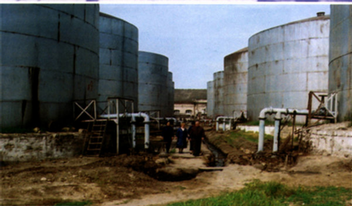
Резервуарный парк НГДУ "Балаханьнефть"
