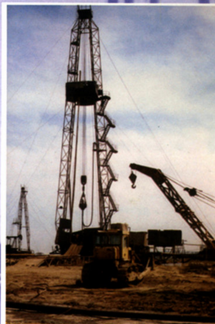
На строительстве новой буровой
