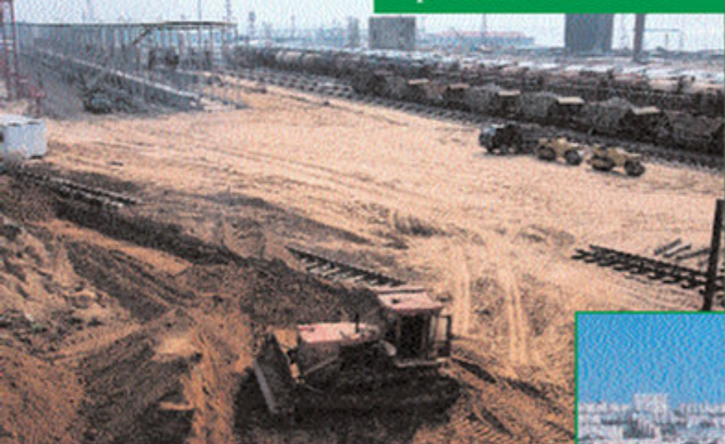
Начало строительства терминала "AZPETROL"
