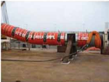
асположение целей и их опор на 30-дюймовой секции трубопровода
