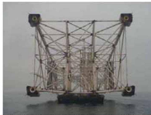
Опорный блок ПБЖ буксируется на место установки
