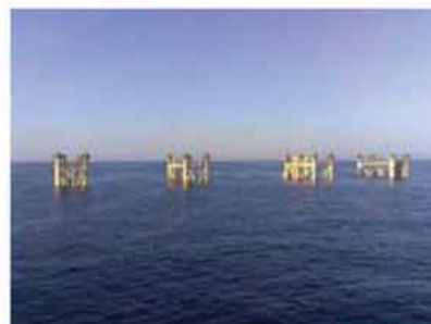
Опорные блоки ПБЖ и ПДГНВ отбуксированы на место и установлены на сваи.
