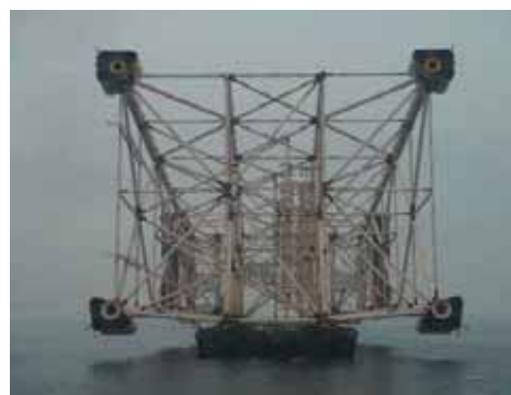
Опорный блок ПБЖ буксируется на место установки
