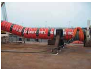
Расположение целей и их опор на 30-дюймовой секции трубопровода
