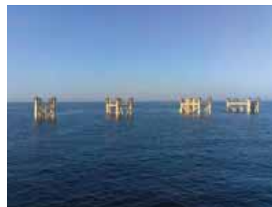
Опорные блоки ПБЖ и ПДГНВ отбуксированы на место и установлены на сваи.
