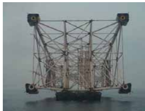
Опорный блок ПБЖ буксируется на место установки
