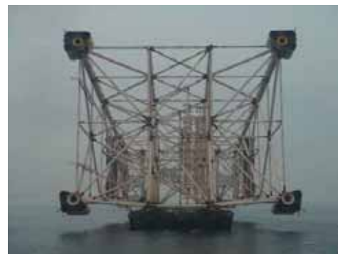
Опорный блок ПБЖ буксируется на место установки
