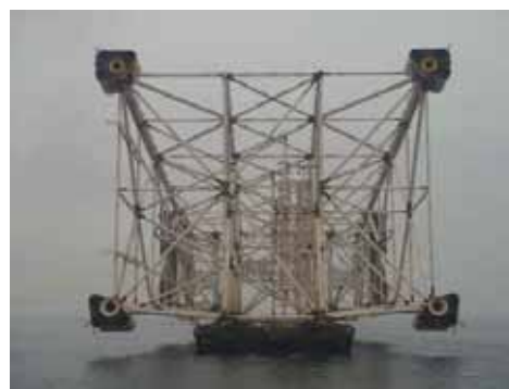
Опорный блок ПБЖ буксируется на место установки
