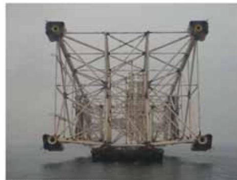
Опорный блок ПБЖ буксируется на место установки
