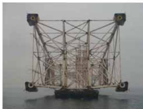
Опорный блок ПБЖ буксируется на место установки
