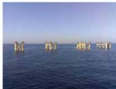
Опорные блоки ПБЖ и ГДГНВ отбуксированы на место и установлены на сваи.
